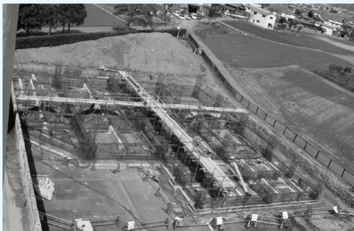
新管理棟建設（基礎工事）の状況（H22.3.11現在）
