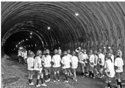
トンネル工事現場を見学する生徒たち
