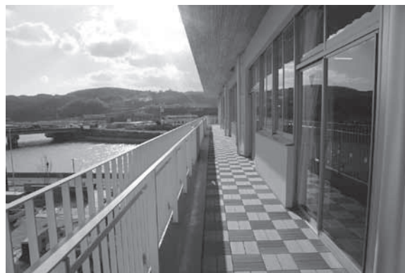
普通教室の窓際にあるバルコニー
