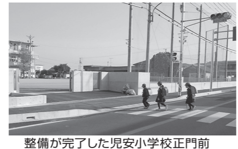
整備が完了した児安小学校正門前
