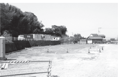
現在建設中の市営住宅 旗山2号棟
