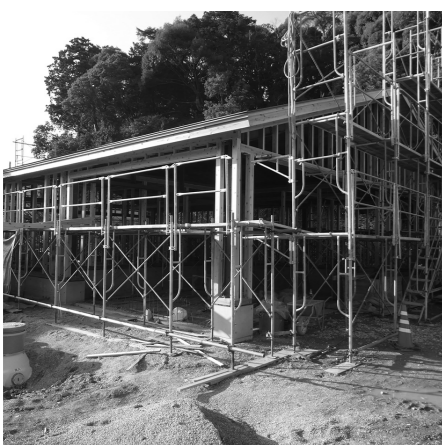
建設中の櫛淵公民館
