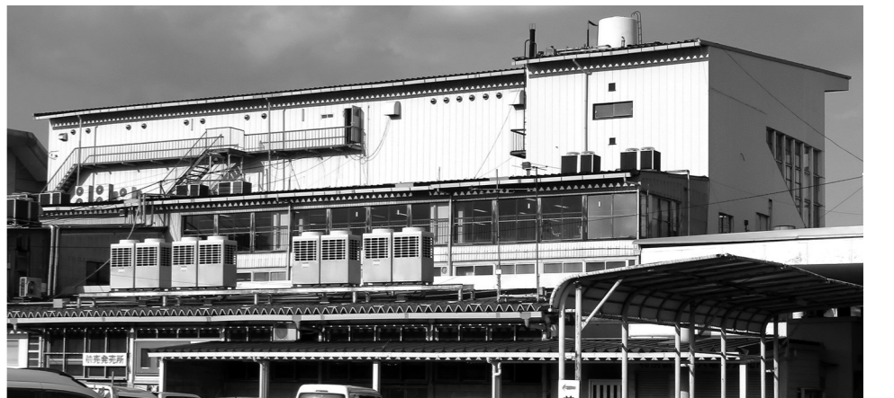
取り壊し予定の小松島競輪メインスタンド
