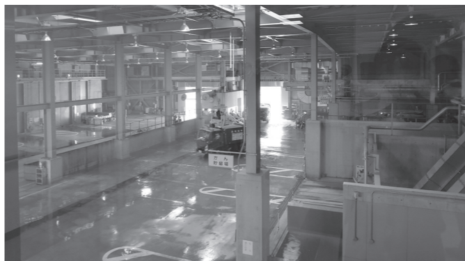
ゴミが搬入されるプラットホーム
