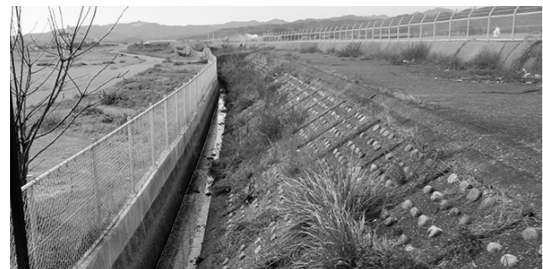
和田島 堤防下の排水路
