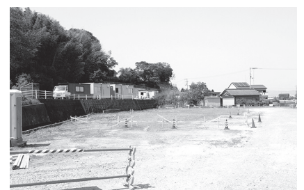
現在建設中の市営住宅 旗山2号棟
