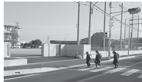
整備が完了した児安小学校正門前
