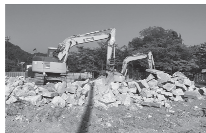
日峯大神子広域公園工事現場
