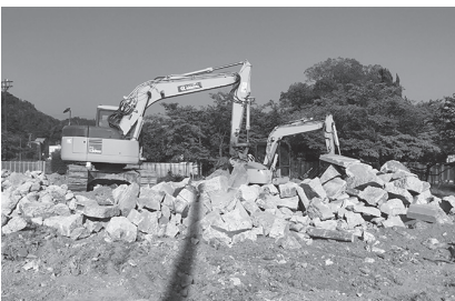
日峯大神子広域公園工事現場
