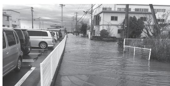
冠水した道路
