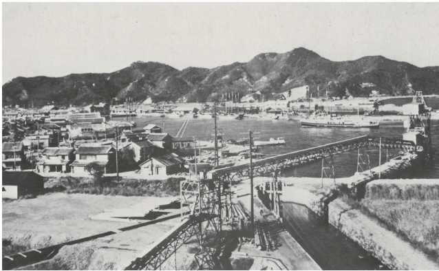
当時あった火力発電所への石炭の陸揚げ用ベルトコンベヤーがありました。その火力発電所も昭和38年まで稼働し、その後に取り壊されて現在の小松島市役所の敷地となっている。
