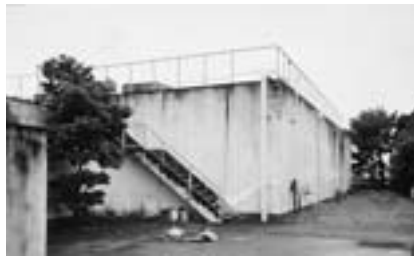
和田島団地汚水処理施設
