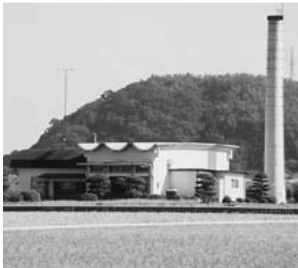
老朽化が進む「小松島市営火葬場」
