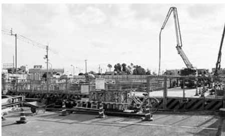
建設中の小松島雨水ポンプ場
