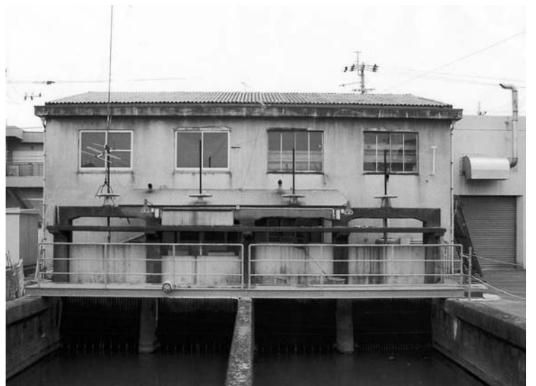
川北ポンプ場
