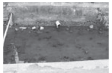
排水路の状況
