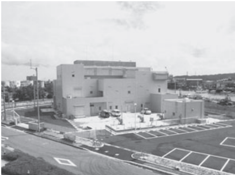
小松島雨水ポンプ場
