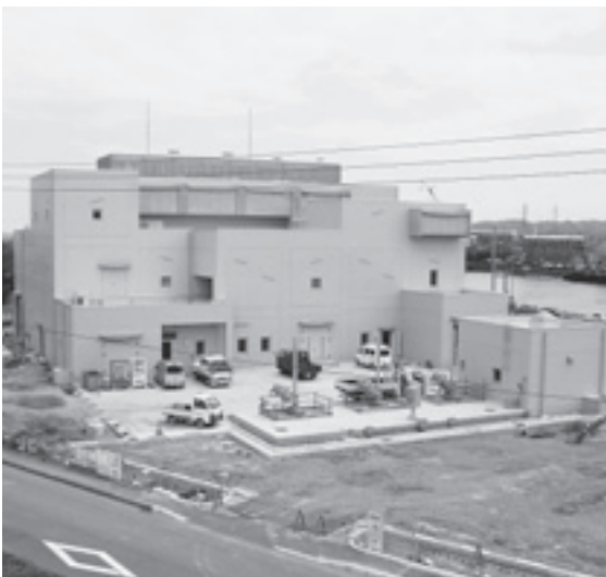
小松島雨水ポンプ場
