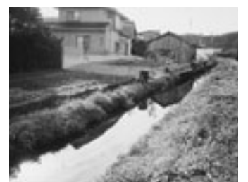
日本製紙南側民有地水路
