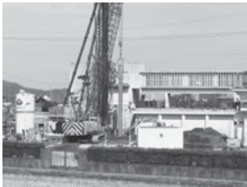
田浦浄水場の着水井・浄水池建設工事
