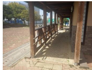
トイレにスロープと手すりの設置 （しおかぜ公園）
