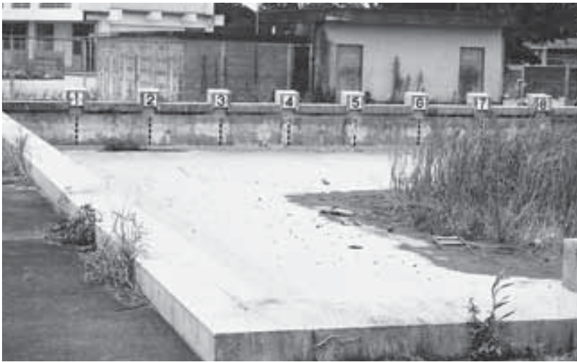
夏休みに解体される坂野中学校横の市民プール
