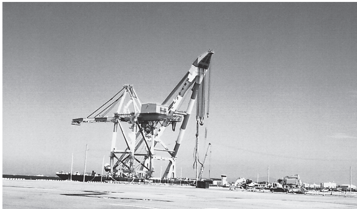
赤石港に整備されるコンテナ基地で使用するため陸揚げされたガントリークレーン
