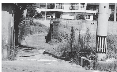
高速道路の用地に協力し提供した家屋の跡地(右側)と幅員の狭い市道
