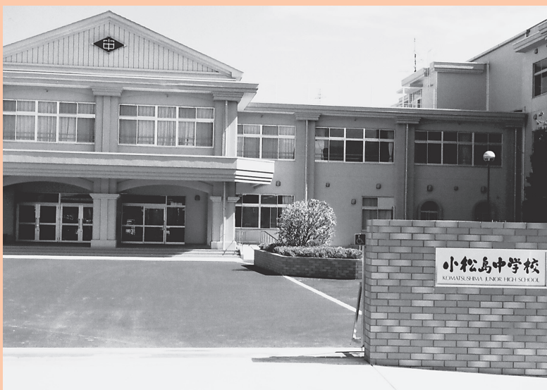
改築工事が完成した小松島中学校
