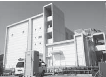
完成間近な金磯南雨水ポンプ場
