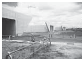
建設が進む四国横断自動車道。今後、盛り土の工事となる。(前原町)
