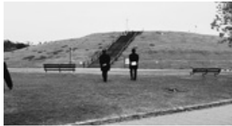
土盛り式の津波緊急一時避難所（浜松市）
