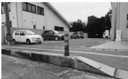
駐車場への出入りに不便な歩車道境界ブロック
