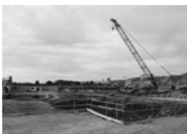
建設工事が進む新中学校
