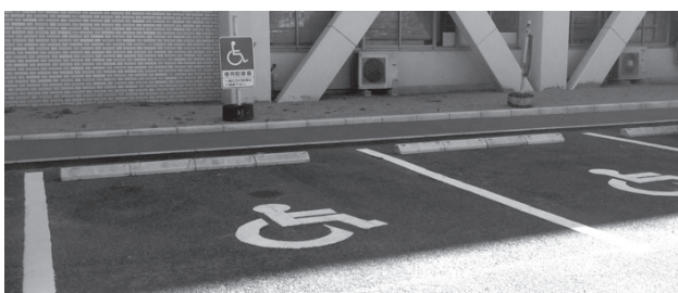
新たに整備された身体障害者用駐車場(本庁舎前)
