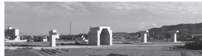
高速道路の橋桁（前原町）
