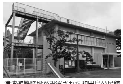
津波避難階段が設置された和田島公民館
