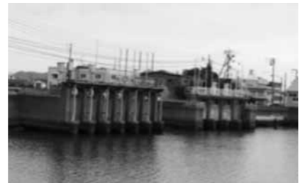
田野川の樋門
