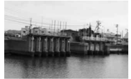
田野川の樋門
