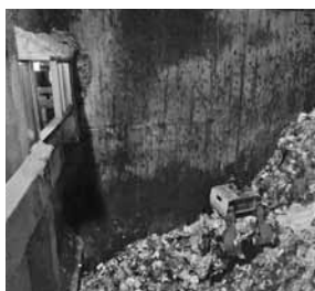
施設内の処理設備
