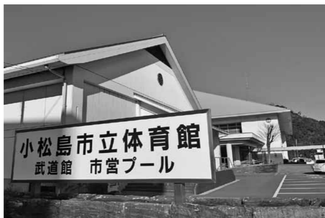
小松島市立体育館
