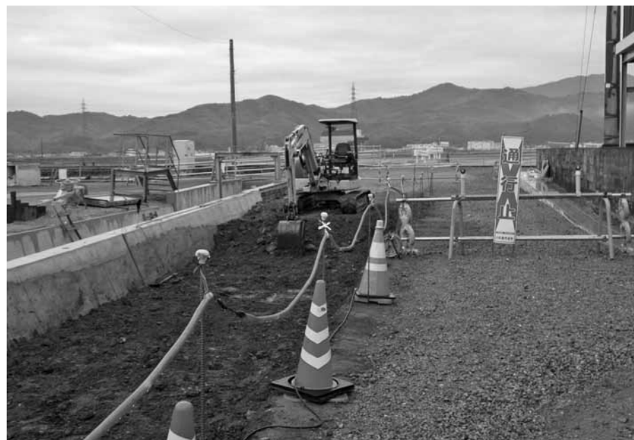
金磯一番町第一踏切の拡張工事
