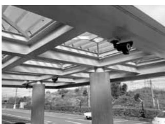
12月20日、入り口3ヶ所に防犯カメラ設置完了
