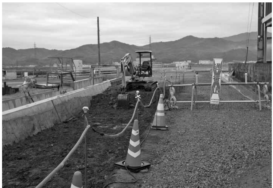
金磯一番町第一踏切の拡張工事
