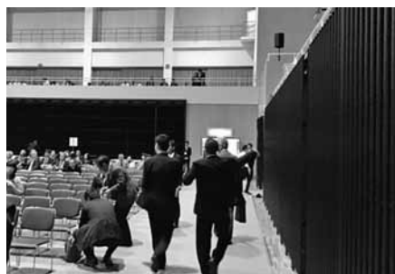
国分体育館の輻射式冷暖房装置(黒い壁面部分)
