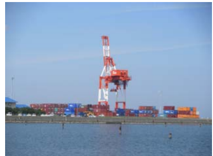
コンテナターミナル 【徳島小松島港赤石地区】
