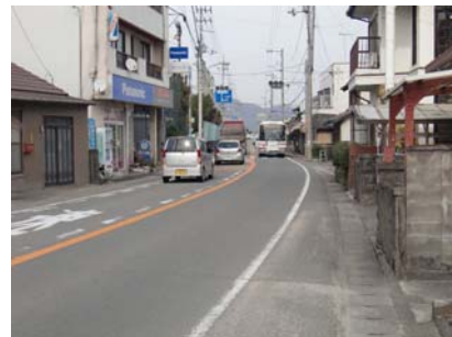
主要地方道 小松島佐那河内線 【児安小学校付近】
