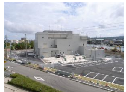
小松島雨水ポンプ場
