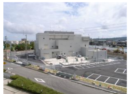
小松島雨水ポンプ場
