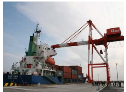
徳島小松島港コンテナターミナル (赤石地区)
