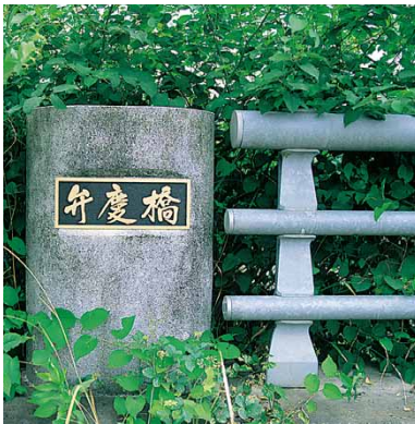
天王谷川上流に平成4年以降に完成した「弁慶橋」
