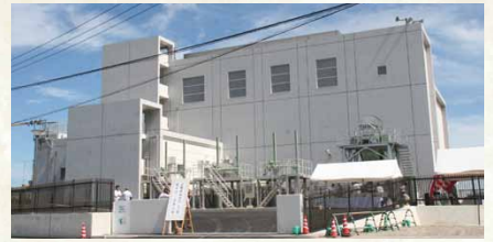
平成26年／金機ポンプ場完成
