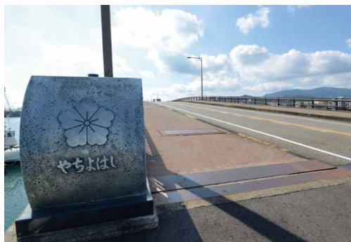
欄干に市の花・木、小松島港の風景をあしらった「八千代橋」(平成3年開通)
