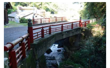
母養山恩山寺の登り口にある朱塗りの橋「母養橋」
