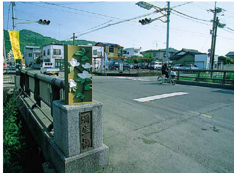
元根井川用水路に昭和10年に架けられた「彌生橋」(平成5年改修)
