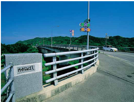
狭く老朽化した潜水橋を上流に架け替えた「野上橋」 (平成5年開通)
