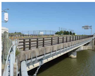
白鷺のレリーフが魅力的な徳島南バイパス「立江川橋」(平成3年開通)
