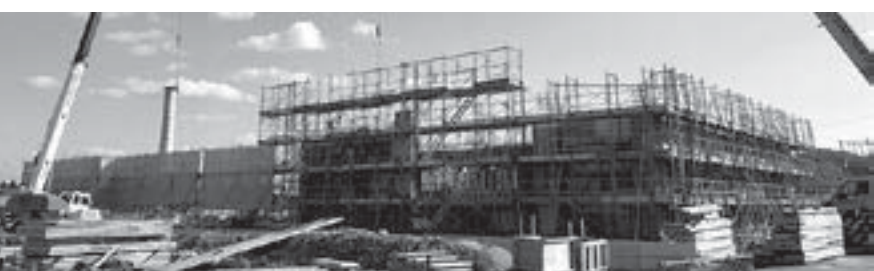
建設中の葬斎場
