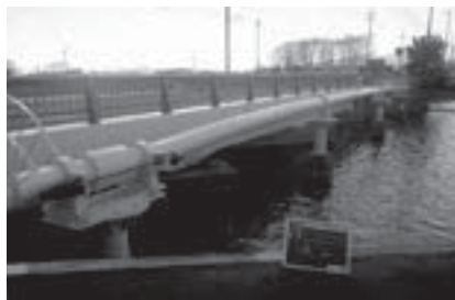
和田津橋水管橋耐震化工事
