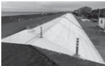
和田島大手海岸の堤防補強工事
