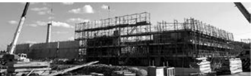
建設中の葬斎場
