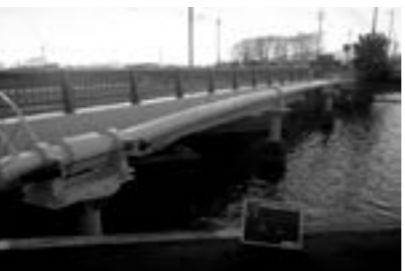
和田津橋水管橋耐震化工事
