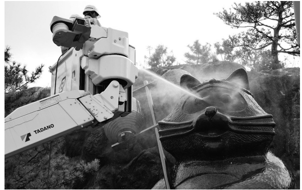
高所作業車で清掃をする様子
