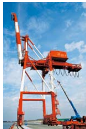
四国最大級のコンテナ荷役用ガントリークレーン
