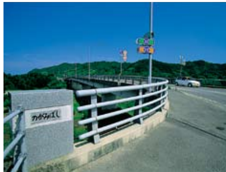
狭く老朽化した潜水橋を上流に掛け替えた「野上橋」(平成5年開通)
