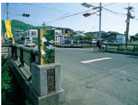
元根井川水路に昭和10年に架けられた「彌生橋」(平成5年改修)
