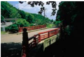
母養山恩山寺の登り口にある朱塗りの橋「母養橋」
