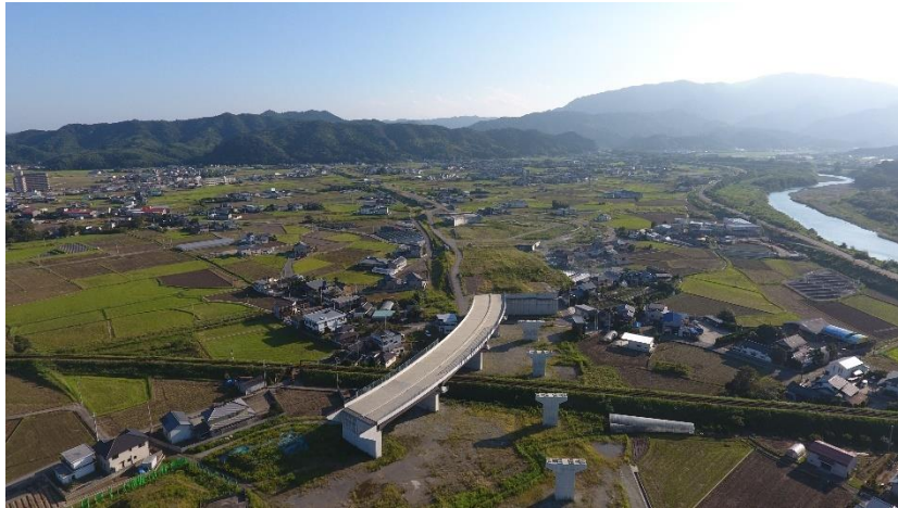
小松島 IC (仮称) 付近
