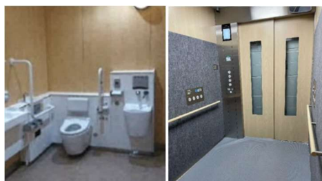
図 4-10 多目的トイレとストレッチャーが入るエレベーター (文科省：バリアフリー化事例集より)
