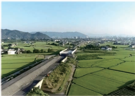
徳島南部自動車道(整備中)
