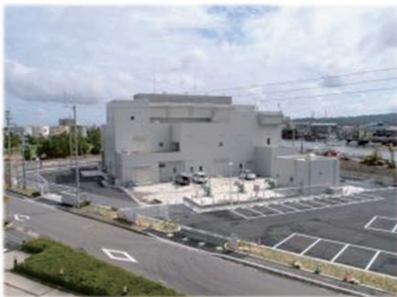
小松島雨水ポンプ場
