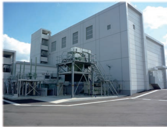
金磯南雨水ポンプ場
