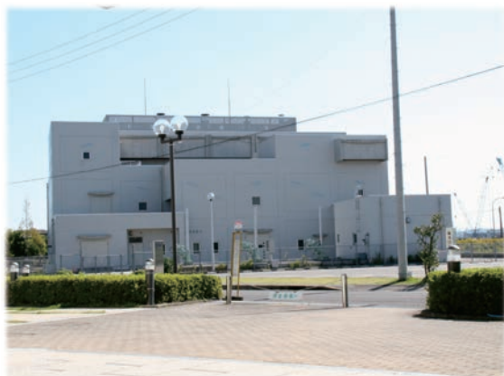
小松島雨水ポンプ場
