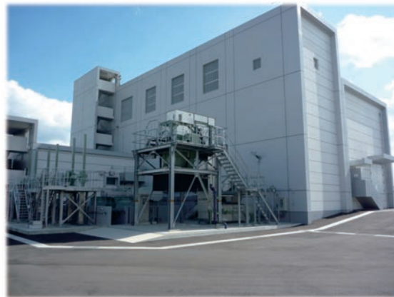
金磯南雨水ポンプ場
