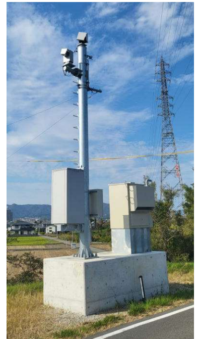
河川監視カメラ
