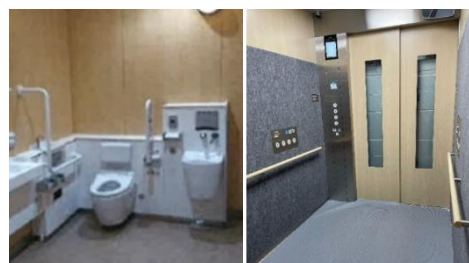
図 4-10 多目的トイレとストレッチャーが入るエレベーター (文科省：バリアフリー化事例集より)
