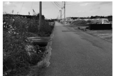
市道和田島36号線と用水路
