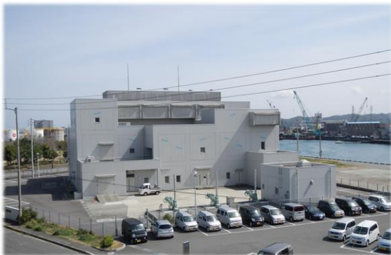
小松島雨水ポンプ場
