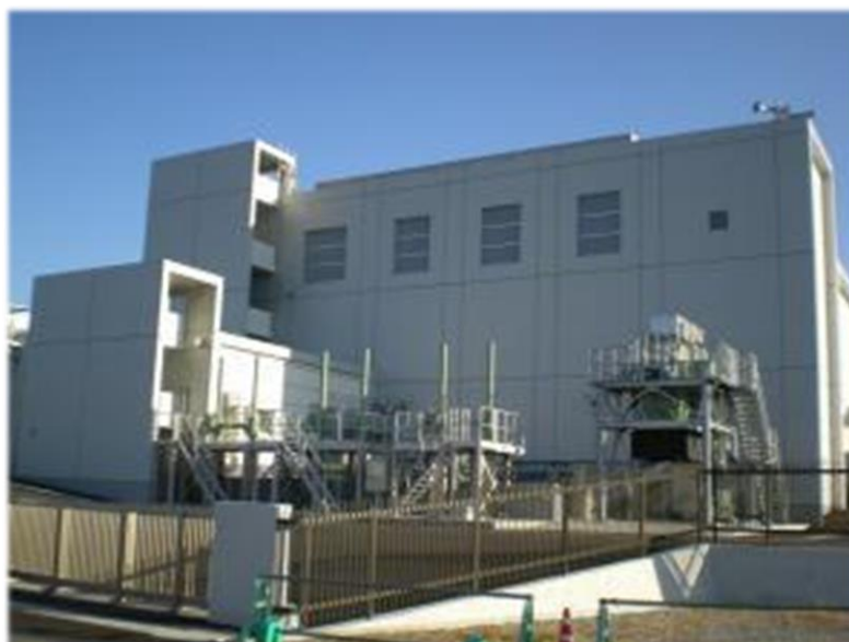
和田島ポンプ場
