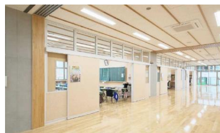
図 4-3 可動間仕切りにより教室を拡張(イメージ)
