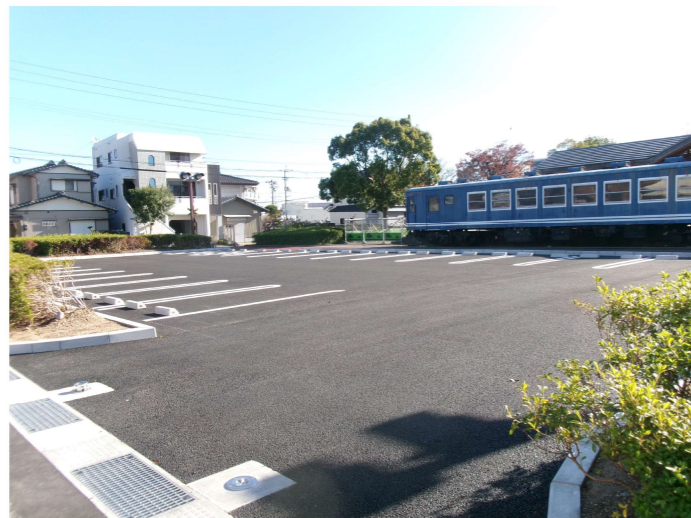
駐車場完成写真
