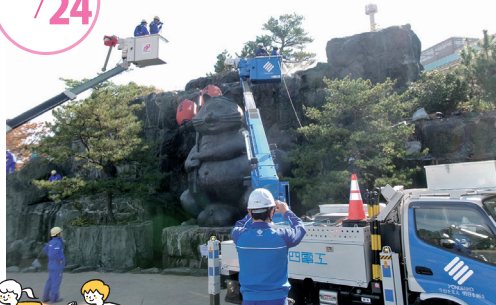
清掃作業の様子
